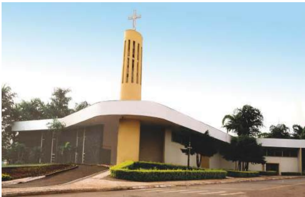
OBRA. A Igreja Matriz da comunidade católica pouco depois de sua inauguração, em 1994. Com linhas arquitetônicas modernas, sua construção demandou mais de uma década. Um mutirão com apoio financeiro de empresários possibilitou a conclusão da obra.
