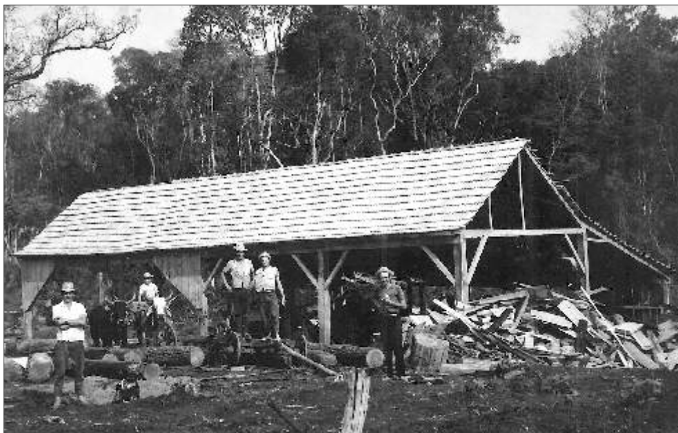
ECONOMIA. Nos primeiros anos de Missal, as serrarias dominaram o espaço rural e urbano. Na imagem datada de 1969, a Serra Kieling, instalada na comunidade de Santa Cecília.
