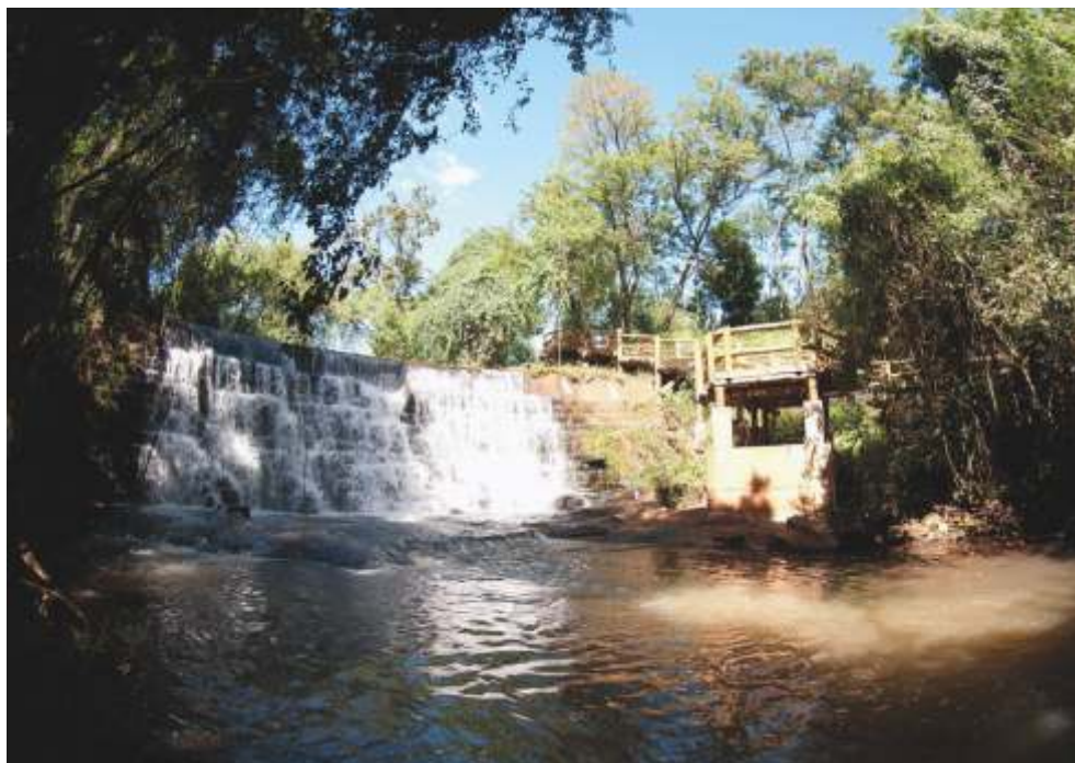
HIDRELÉTRICA. Detalhe da barragem construída no Rio Alegria. A obra teve início em 1961 e a geração de energia começou três anos depois, com capacidade de 80 kVA.
