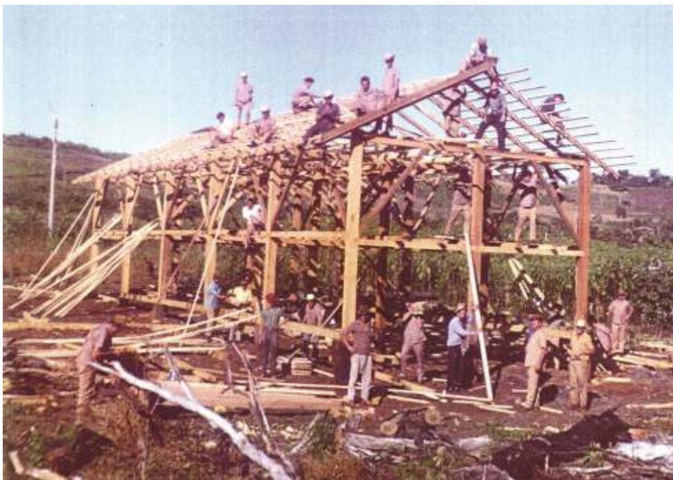
“TROCAR DIAS”. Construção de um galpão de tabaco, no interior de Medianeira, na década de 1970. O trabalho em regime de mutirão era habitual na fumicultura.
