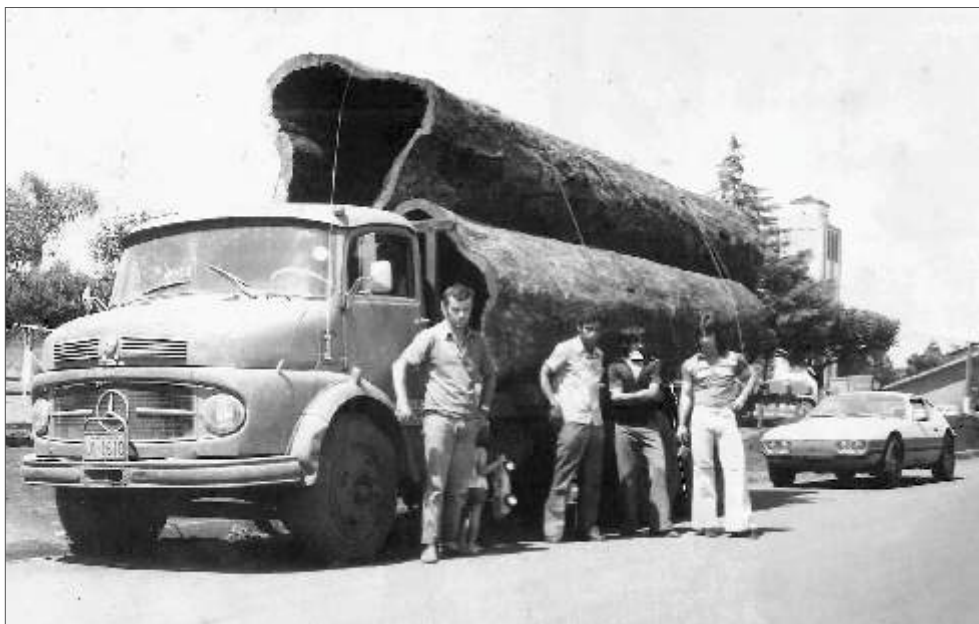
UTILIDADE. Toras ocas de canafistula eram utilizadas na construção de bueiros, que chegavam a durar mais de 20 anos. A imagem é da década de 1970.
