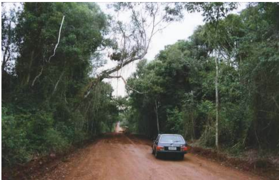
ESTRADA DO COLONO. Aberto ilegalmente por colonizadoras na década de 1950, o caminho de 17,5 quilômetros cortava o Parque Nacional do Iguaçu.
